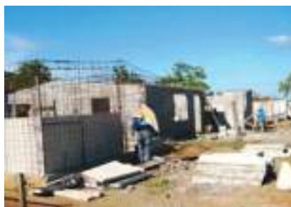
• Techo de Esperanza Los abanicos, Chiriquí.
