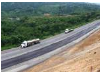
• Barro Blanco-Tramo II.
